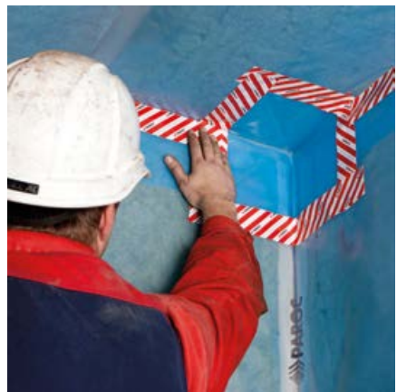
Höyrynsulkumuovin asentaminen nurkkakohtaan
